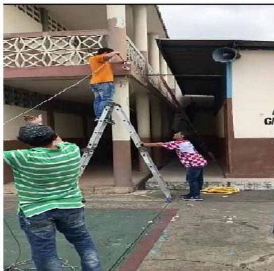
Cableado en el interior de las tuberías ya instaladas en el edificio Gabriela Mistral planta baja y alta.
