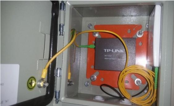
**Figura 9. Equipos conectados en la caja metálica.**
