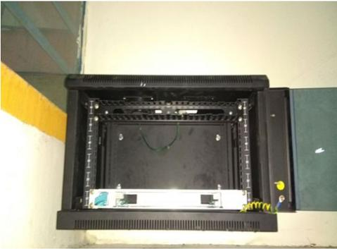
**Figura 8. Instalación de gabinete rack.**
