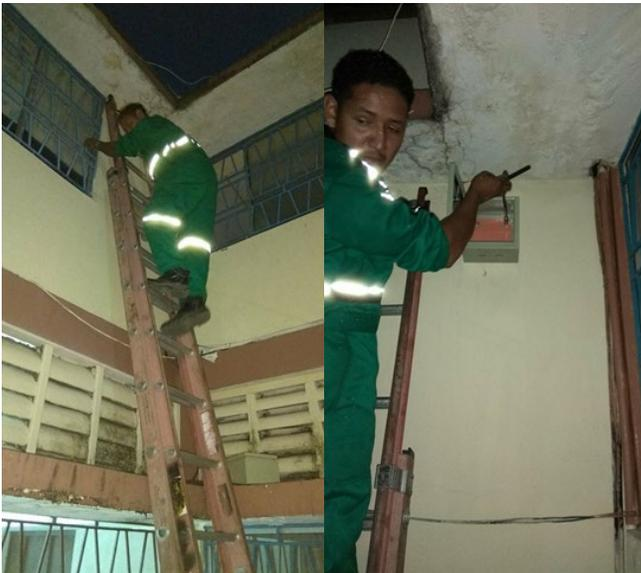
**Figuras3 y 4. Instalación de las cajas metálicas en el punto A.**
