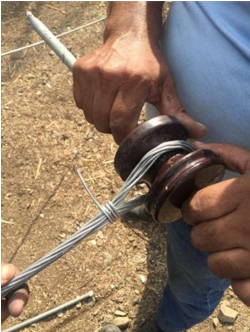
**Figura 7:** Amarre de aislador tipo rollo
