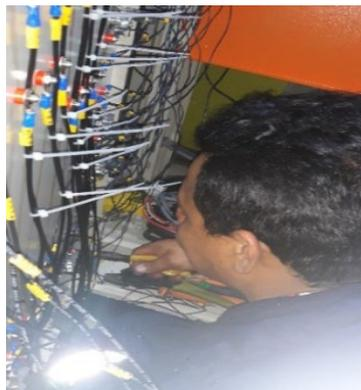
Figura 8.-Cableado circuito de control
