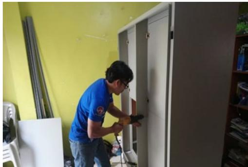
Figura 4.-Colocación de bisagras en puertas internas
