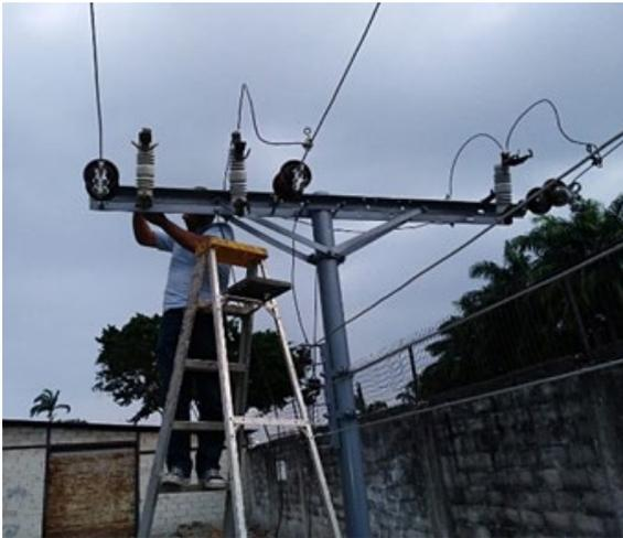
**Figura 10:** Instalación de caja porta fusible
