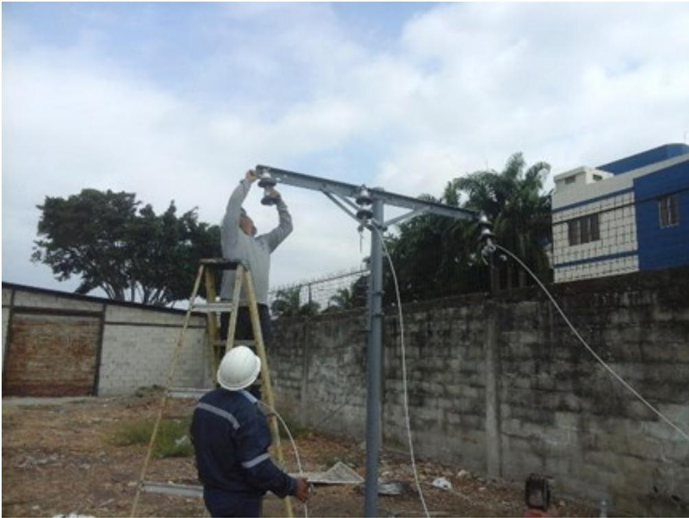
**Figura 6:** Instalación de aislador de suspensión, grapa tipo pistola y ajuste de cable
