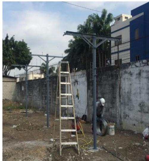
**Figura 5:** Se dispone a instalar aisladores
