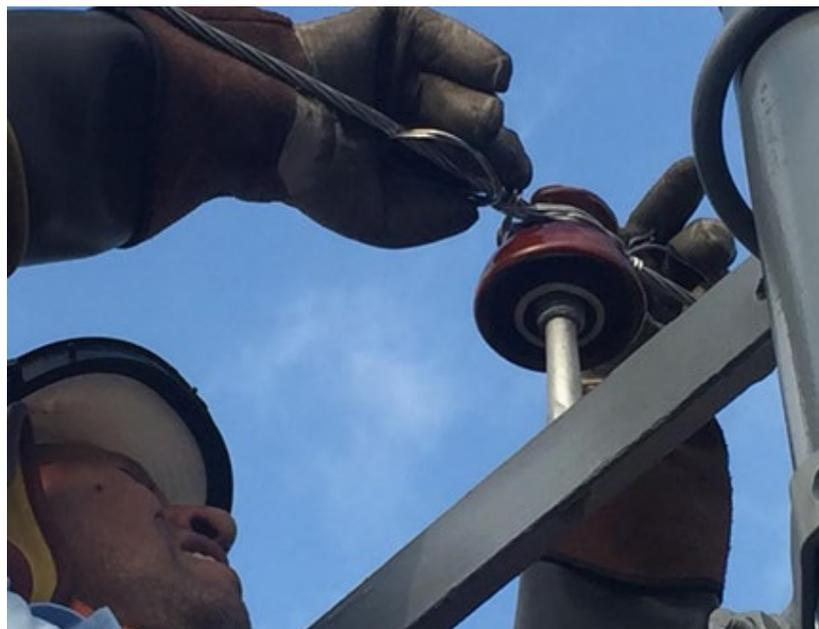
**Figura 9:** Amarre de aislador tipo espiga de 15kV a cable, con mangas y guantes
