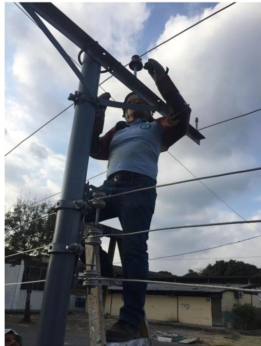
**Figura 8:** Uso de mangas y guantes para amarre de aislador tipo espiga de 15kV a cable ACSR
