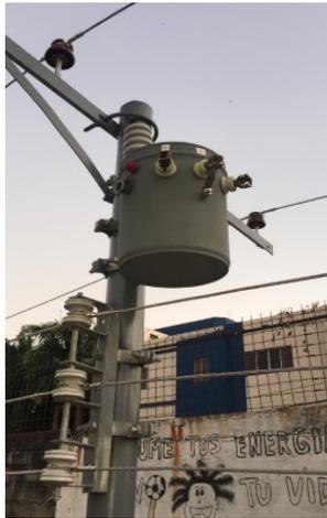
**Figura13:** instalación del transformador de distribución auto protegido didáctico
