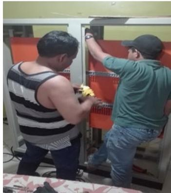
Figura 5.-Colocación del riel Dim y canaletas
