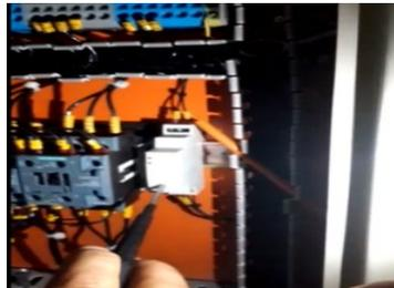
Figura 12.-Calibración de temporizador
