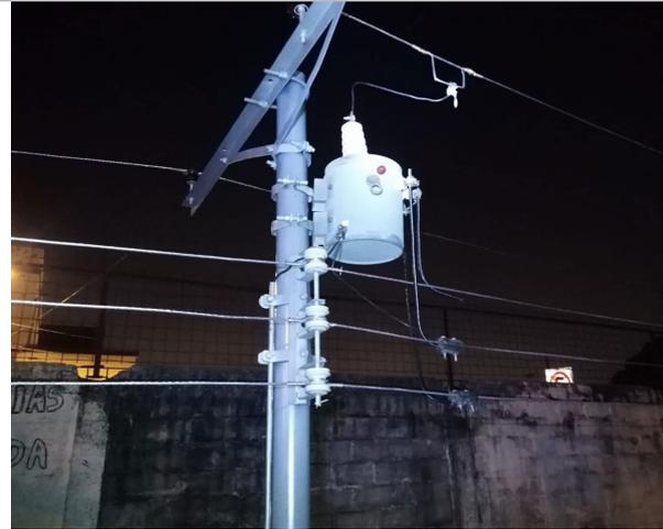
**Figura12:** transformador didáctico por las noches con sus respectivas instalaciones de alta y baja tensión
