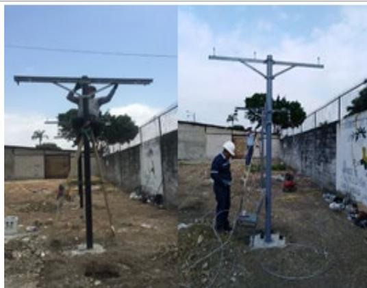
**Figura11:** instalación de herrajes y cableado
