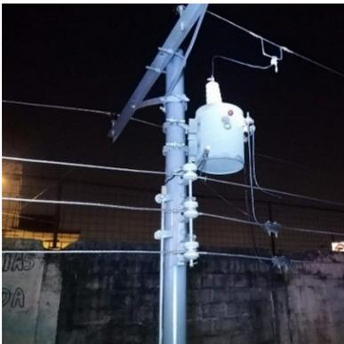
**Figura 12:** Transformador
