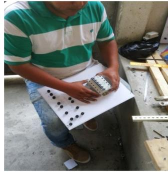
**Figura 12:** instalación de elemento de protección
